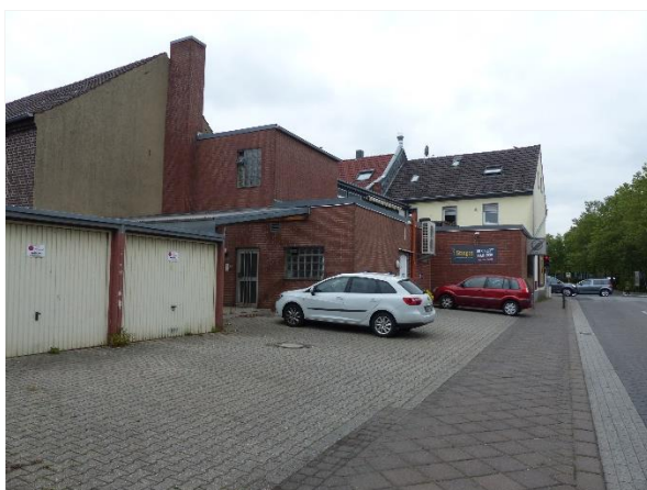
Abb. 1.2.6. : Bebauung Virmondstraße (Quelle: Aufnahme vom 16.07.2019)
