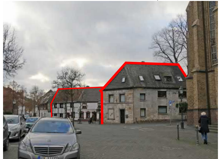
Gebäude als Endpunkte von Blickachse entlang der Hülsonkstraße
