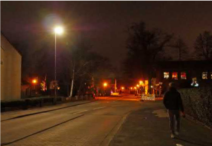
Die Sammelstraßen sind weitestgehend auf LED in neutralweißer Lichtfarbe umgerüstet. In der Verlängerung der Schiefbahner Straße sind NAV-Leuchtmittel in gelb-/orangelastiger Lichtfarbe im Einsatz.
