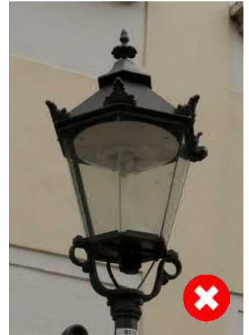
Freistrahkende LED-Lichtquelle ohne Lichtlenkung in historisierender Mastleuchte
