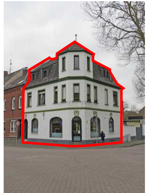
Eckgebäude Neusser Straße / Grabenstraße
