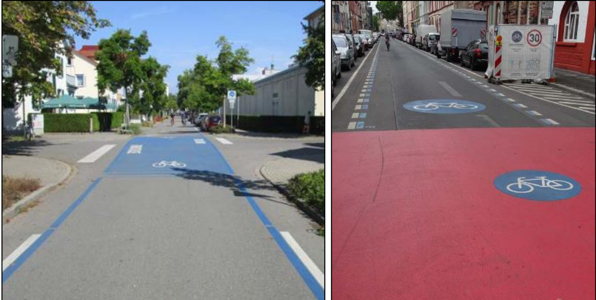
Abbildung 10: Fahrradstraße am Knotenpunkt Schottenstraße / Wallgutstraße in Konstanz (links) und Sicherheitstrennstreifen in der Farbe Blau [Quelle: Fahrradstraße – Leitfaden für die Praxis, Bergische Universität Wuppertal und Deutsches Institut für Urbanistik gGmbH]
